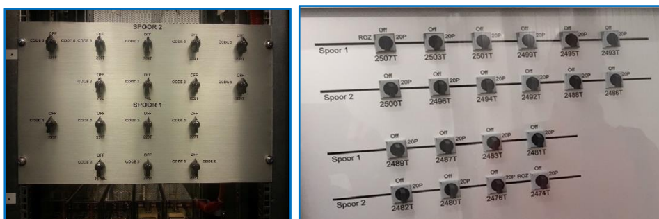
Figuur 11, Dial down paneel in de BVI ruimte (links voor GE/Alstom-installaties en rechts voor Bombardier-installaties).
