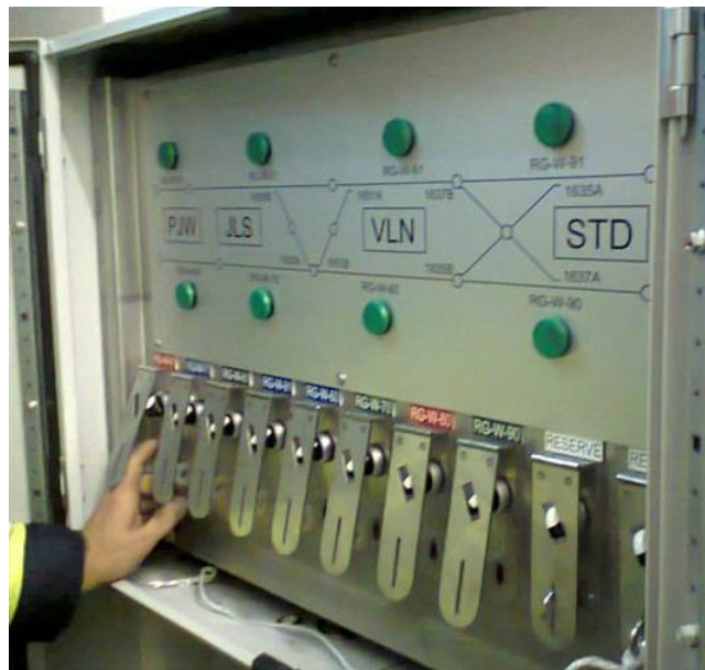
Voorbeeld RET-werkzoneschakelaar (links) en GVB-werkzoneschakelaar (rechts).
